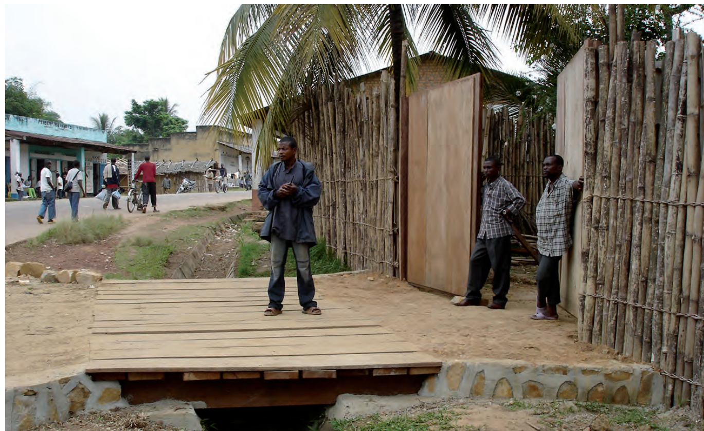
OPEN DRAINS / DRAIN OUVERT
