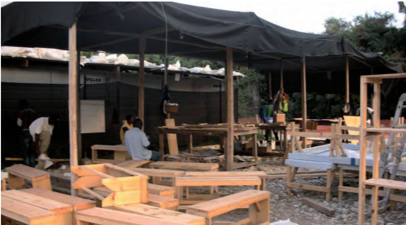
INSTALLATION OF SHADE NET / INSTALLATION DE FILET À OMBRE
