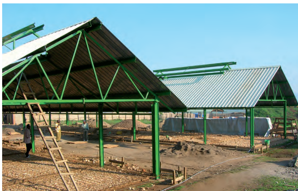
METAL-FRAMED STRUCTURE / STRUCTURE AVEC OSSATURE MÉTALLIQUE MSF, DEMOCRATIC REPUBLIC OF CONGO
