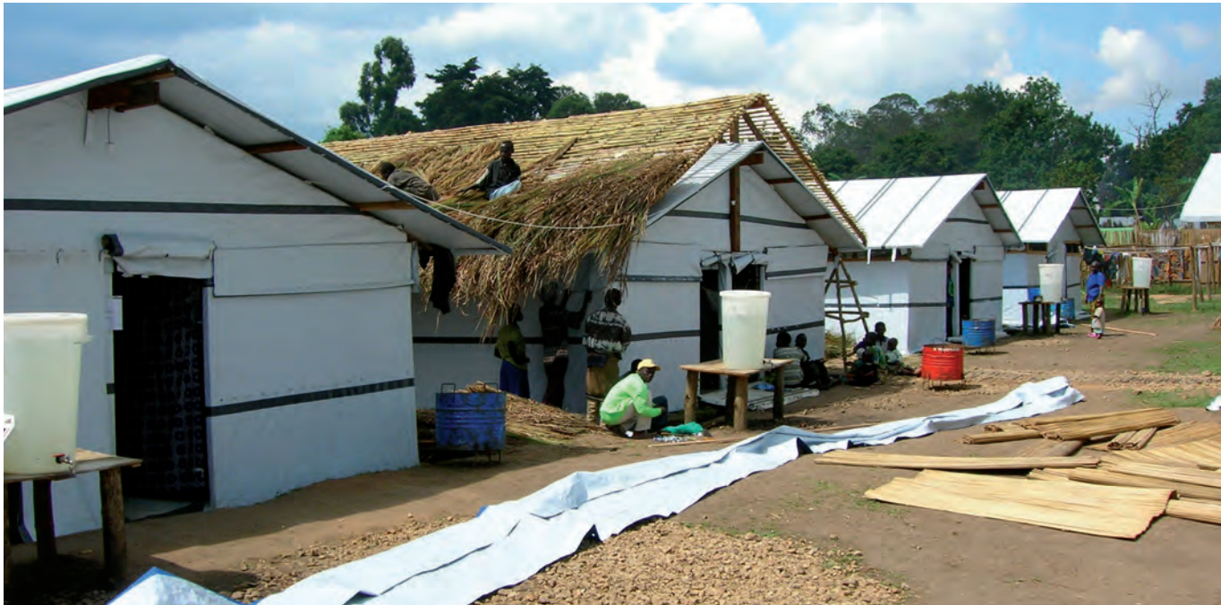
SEMI-PERMANENT SHELTER IN WOOD AND PLASTIC SHEETING / ABRI SEMI-PERMANENT EN BOIS ET BÂCHE PLASTIQUE MSF, SIERRA LEONE
