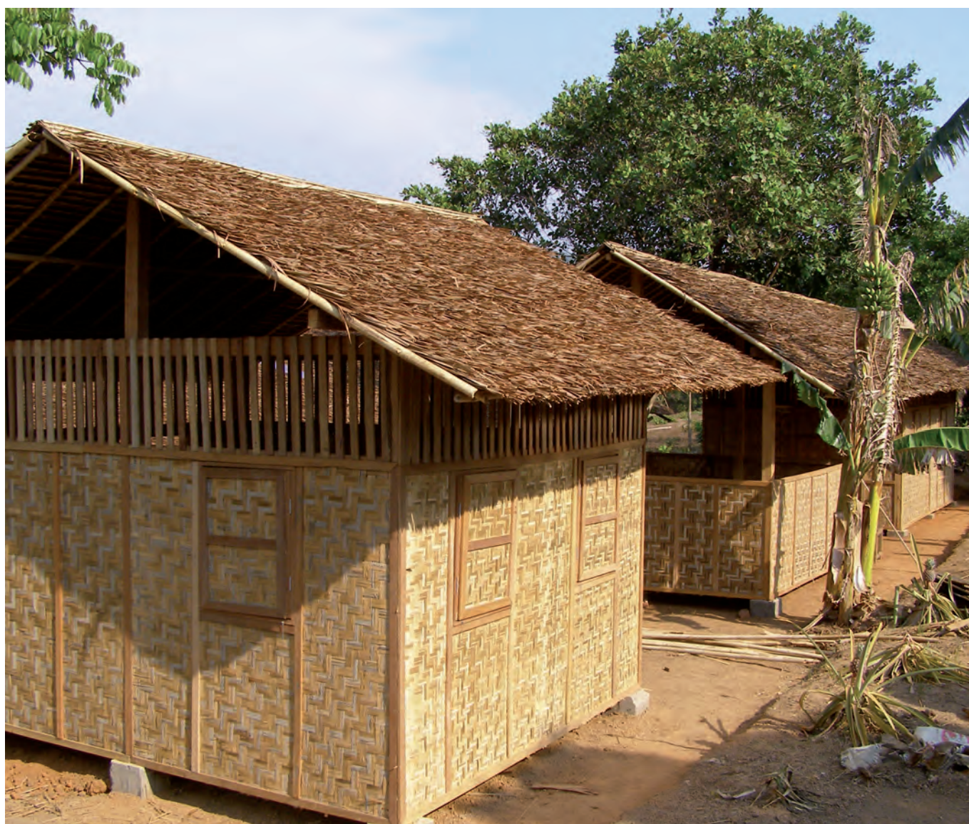
FIG 79, SHELTER MADE OF WOOD AND NATURAL FIBRE / ABRI FAIT DE BOIS ET DE FIBRE VÉGÉTALE MSF, MYANMAR
