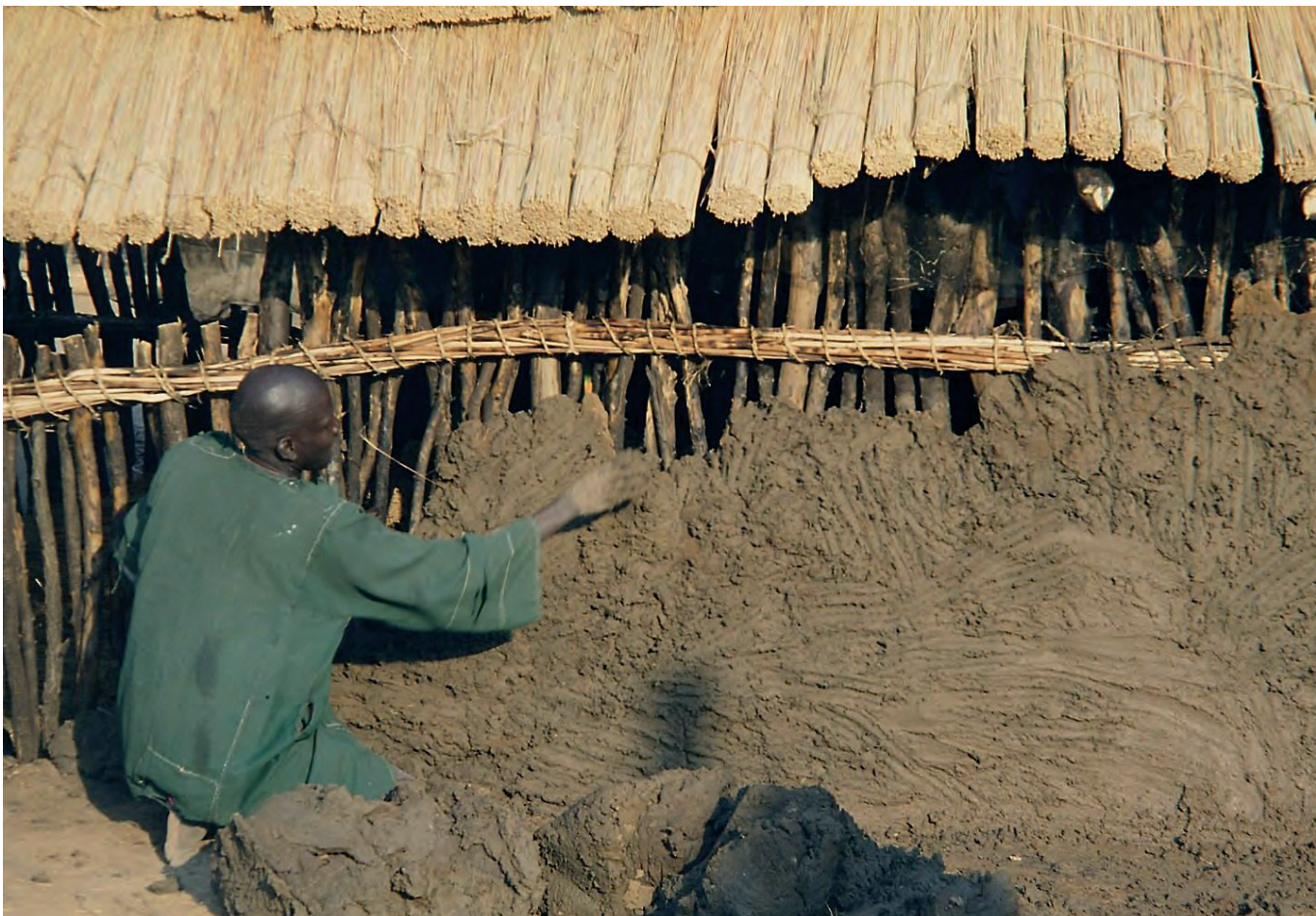
WALL MADE FROM WOOD AND MUD / MUR FAIT DE BOIS ET DE BOUE MSF, SOUTH SUDAN
